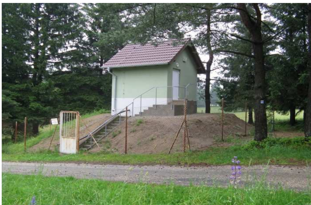
Obr. 2 Rekonstruovaná úpravna s integrovanou technologií odradonování, obec Olšová
