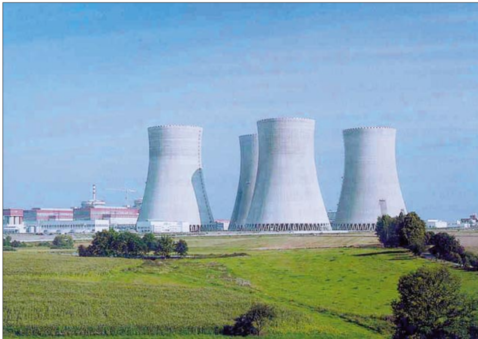
Jaderná elektrárna Temelín - celkový pohled
