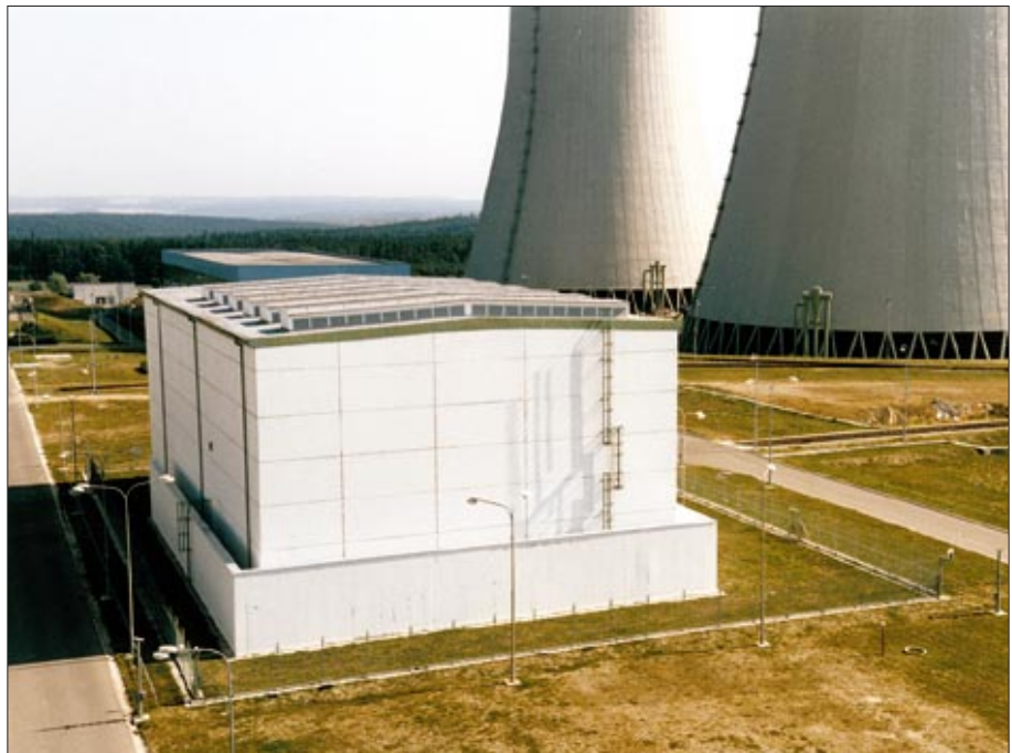
Mezisklad vyhořelého jaderného paliva Jaderná elektrárna Dukovany
