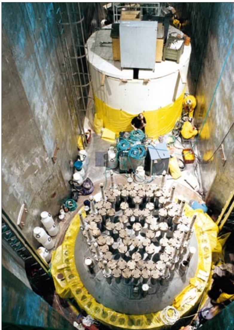
Jaderná elektrárna Temelín - montážní a kontrolní práce v šachtě reaktorů (Foto archiv ČEZ, a.s. JE Temelín)
