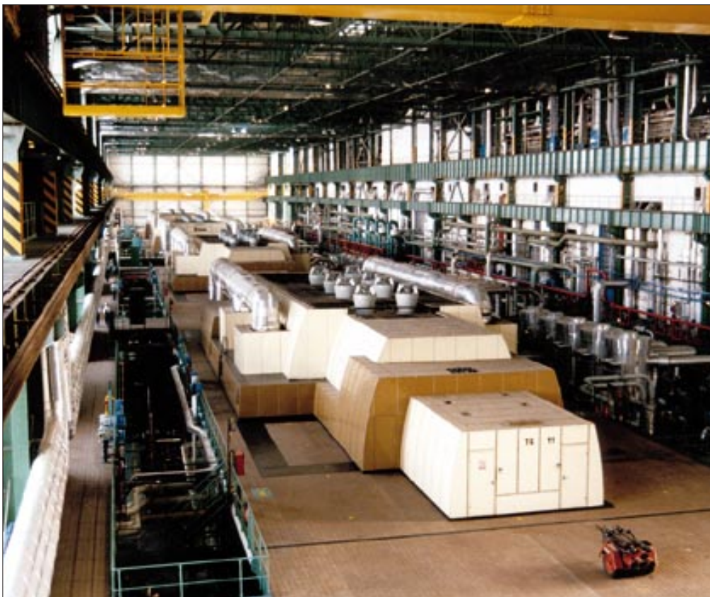
Jaderná elektrárna Dukovany - turbínová hala
