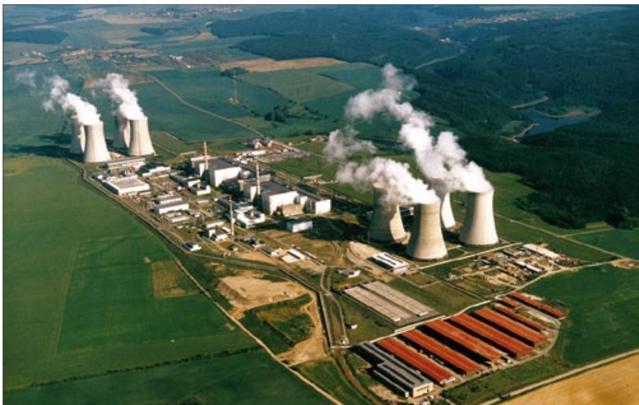
Jaderná elektrárna Dukovany - celkový pohled
