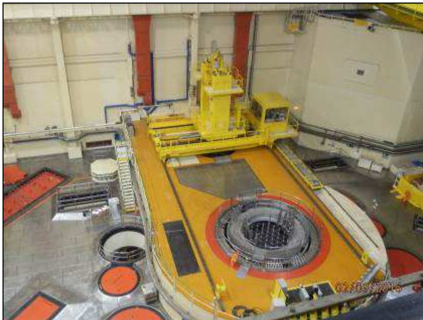
Obr. 4.1 BSVP a ŠTK při výměně paliva v reaktoru
