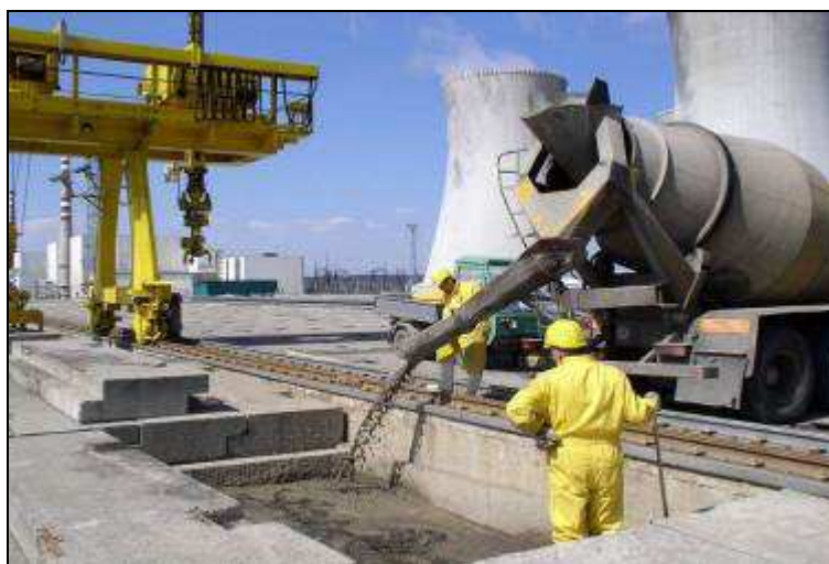
Obr. 8.3 Vyplňování zaplněné jámky betonem
