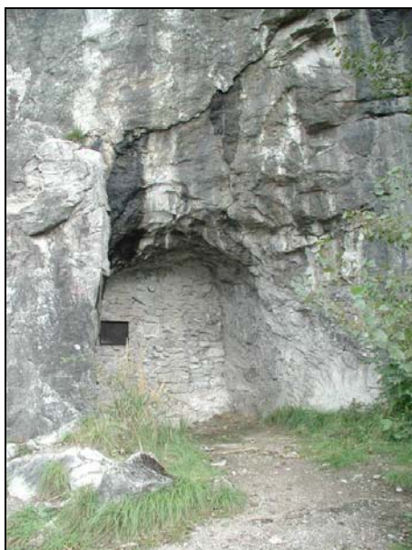
Obr. 8.5 Zabezpečený vchod do úložiště Hostím
