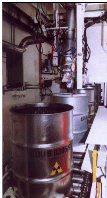
Obr. 4.5 Pohled na bitumenan  linku na zpracovn  KRAO
