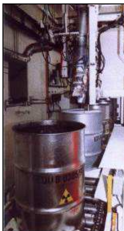
Obr. 4.5 Pohled na bitumenační linku na úpravu KRAO
