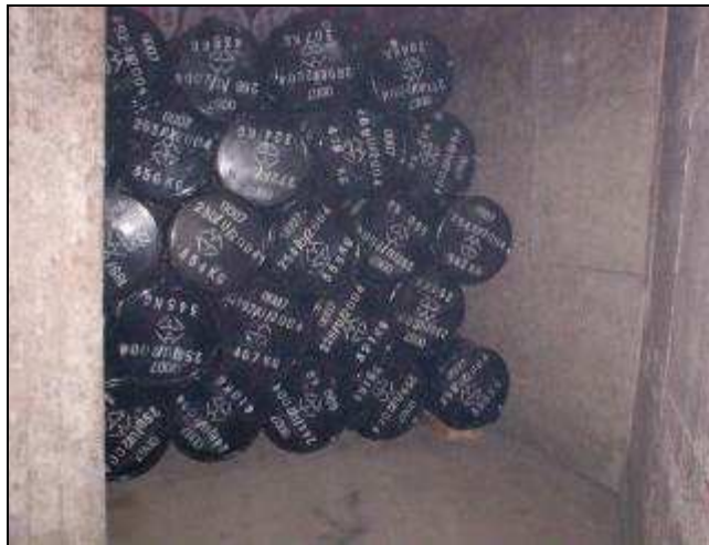
Obr. 8.1 Pohled do úložné kobky ÚRAO Richard
