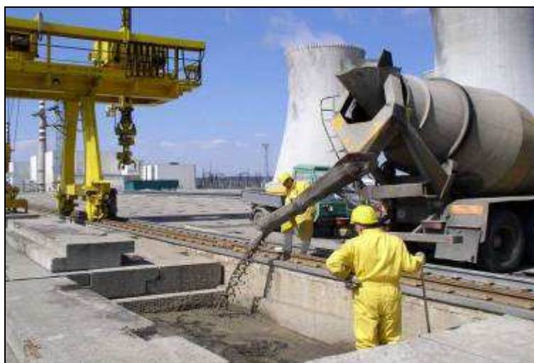
Obr. 8.3 Vyplňování zaplněné jámy betonem
