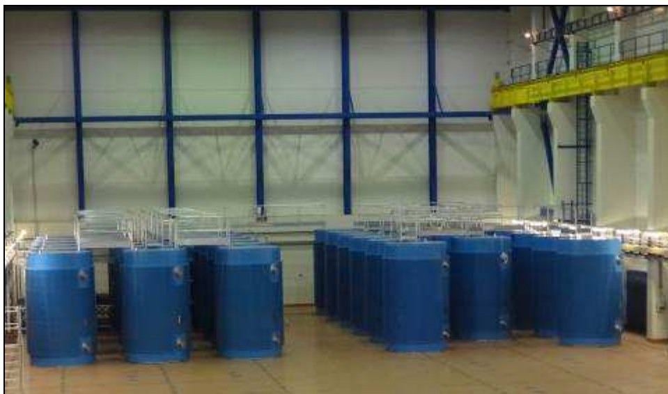
Obr. 4.2 Skladovací hala SVP Dukovany
