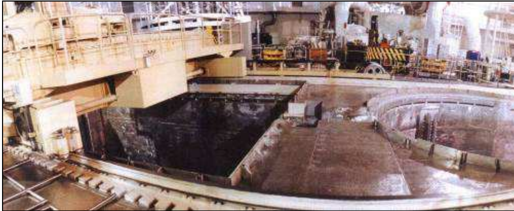
Obr. 4.3 Odkrytý BSVP JE Temelín
