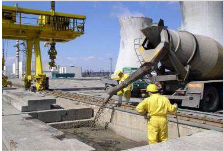
Obr. 8.3 Vyplňování zaplněné jímky betonem
