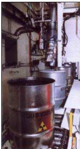
Obr. 4.5 Pohled na bitumenační linku na úpravu KRAO
