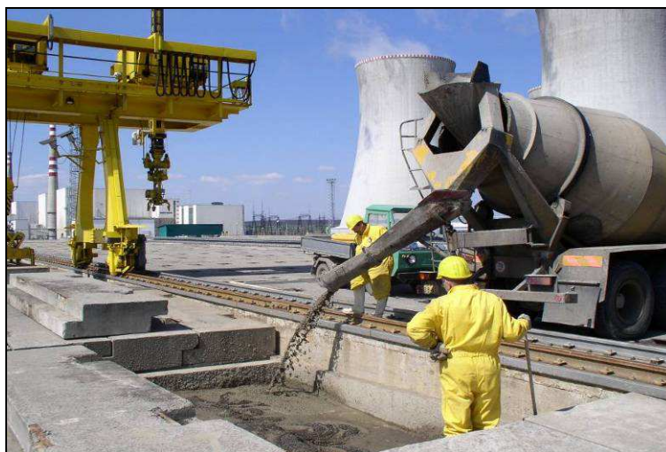
Obr. 8.3 Vypĺňování zaplněné jímky betonem
