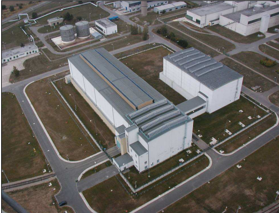
Obr. 7.1 Pohled na SVP Dukovany (vlevo) a MSVP Dukovany (vpravo)
