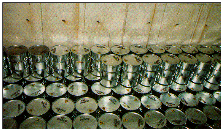
Obr. 8.4 Pohled do částečně zaplněné úložné jámky ÚRAO Dukovany
