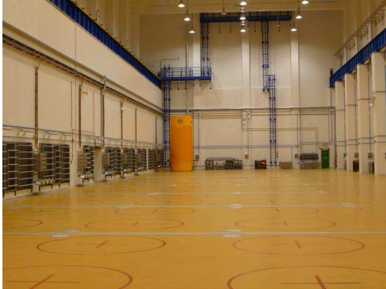
Obr. 4.4 Skladovací hala SVJP Temelín s prvním zavezeným OS
