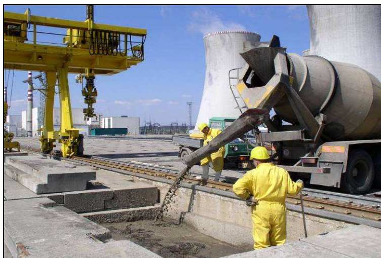
Obr. 8.3 Vyplňování zaplněné jímky betonem
