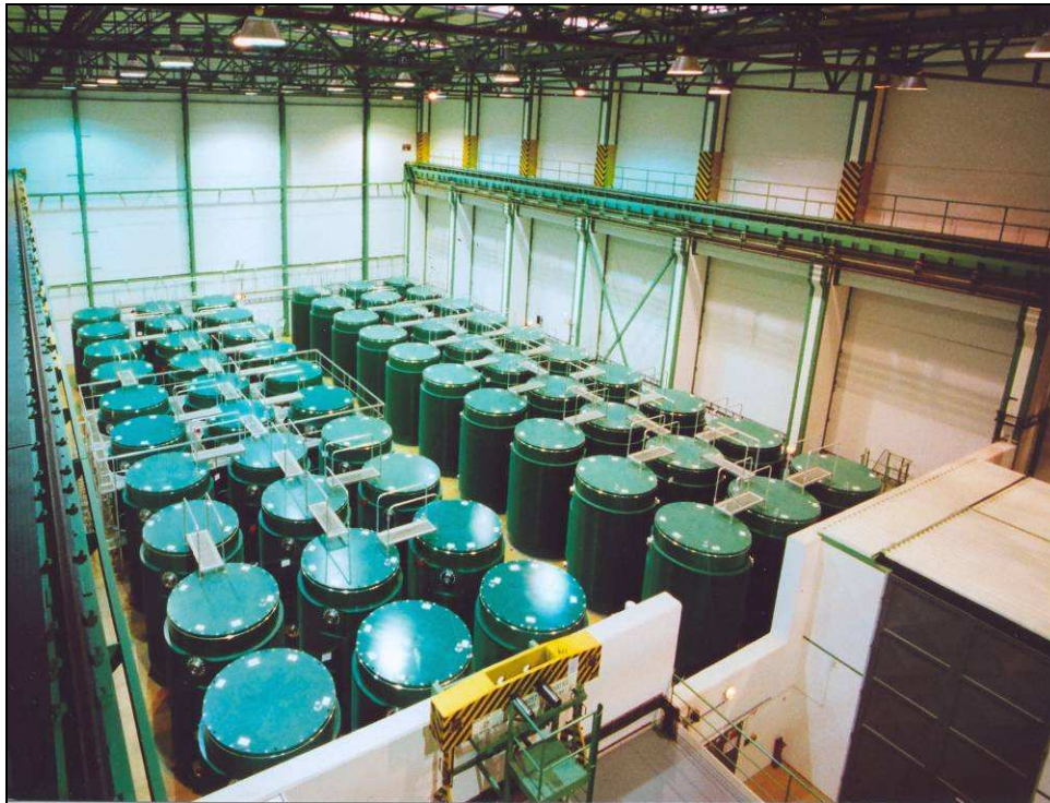
Obr. 4.2 Zaplněná skladovací hala MSVP Dukovany
